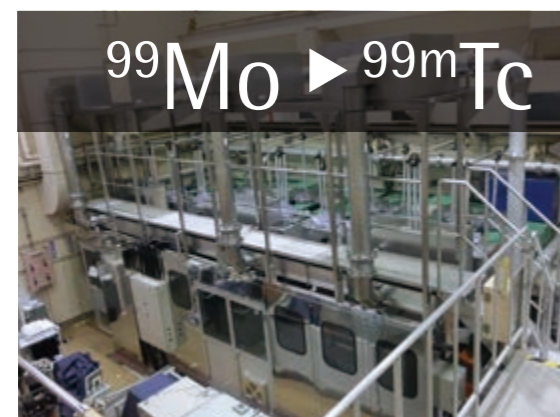
JMTRホットラボに設置したクリーンブース
